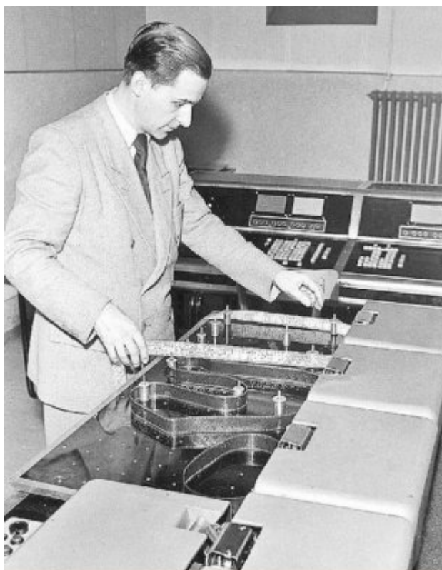
La Ernst Leitz GmbH è stata un precursore dell'informatizzazione dell'industria tedesca; un computer Zuse Z5 è stato acquisito nel 1953. Guidato da nastro forato fatto di pellicola di porcellana grezza 35mm
