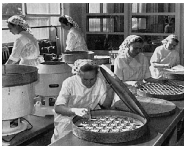
Controllo del rivestimento della lente
