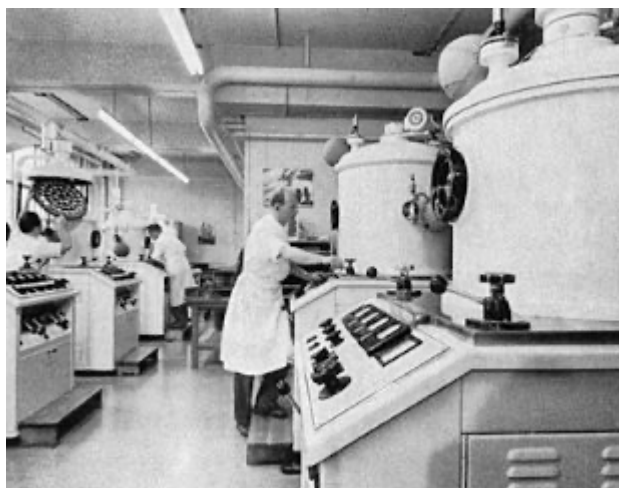
Il reparto di rivestimento delle lenti con gli autoclave per la deposizione termodinamica degli strati antiriflesso sugli elementi ottici
