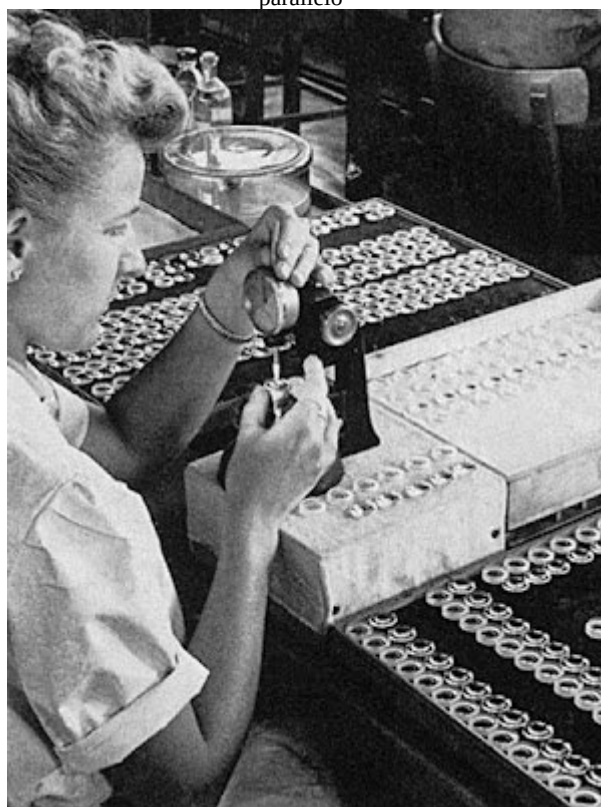
Prova spessore lenti con calibro
