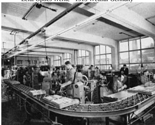
Il corpo in alluminio pressato della Leica sulla linea di produzione
