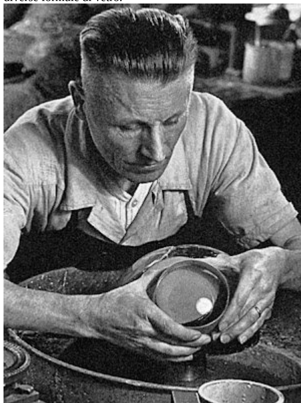
Piastra di prova - master negativa - lucidata alla prescrizione
